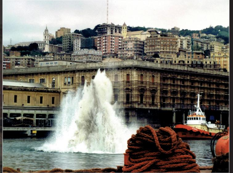
DRAGAGGIO FONDALE DEL PORTO DI GENOVA IN COLLABORAZIONE CON L'AZIENDA OLANDESE BOSKALIS PER RIMOZIONE DI 40.000 mc DI ROCCIA
